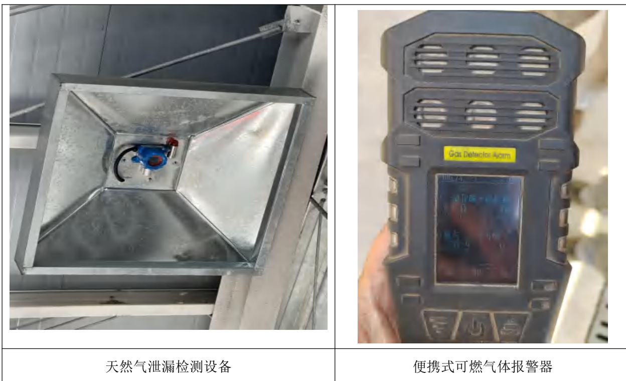
图 4.2-5 生产装置区风险防范设备
