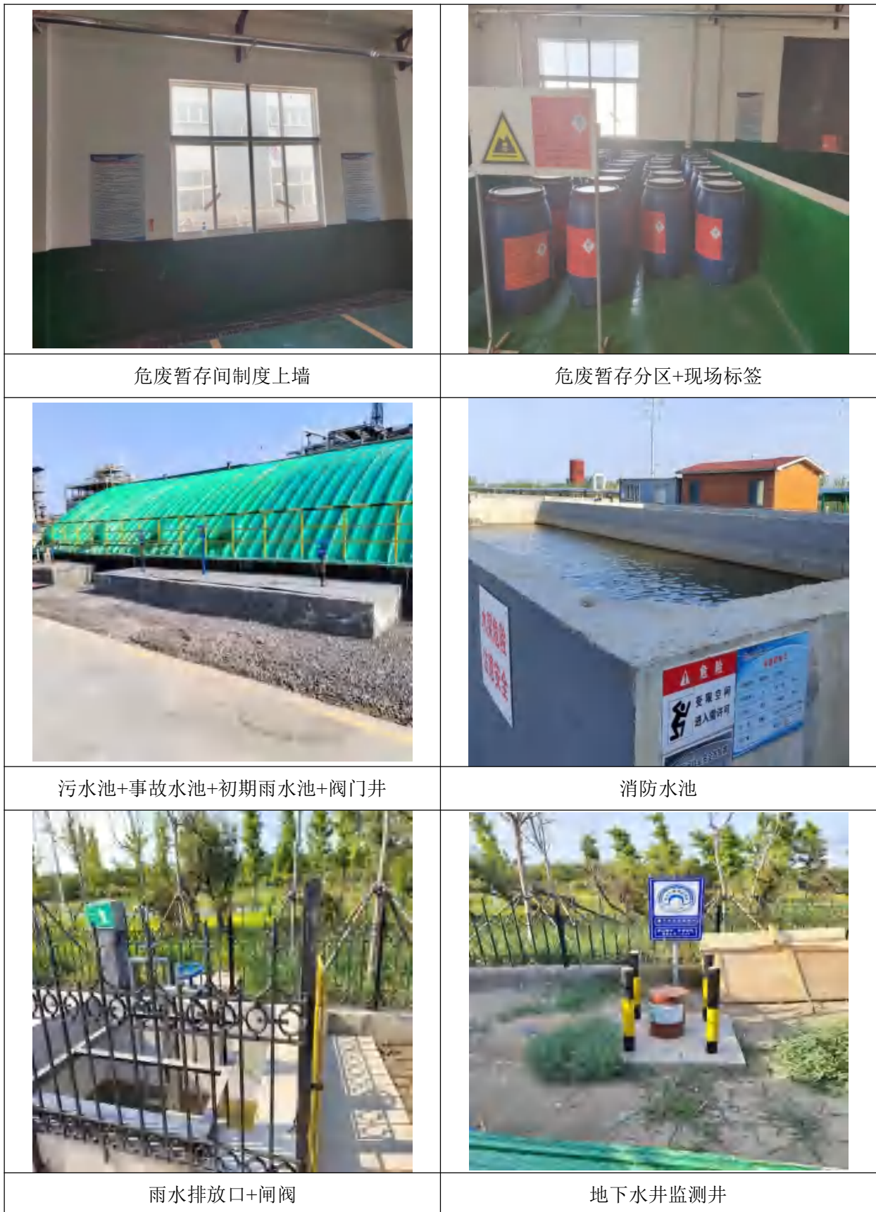
图 3.2-1 本项目建设现状情况
